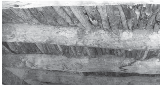
Vigas and latillas at Casa San Ysidro.
